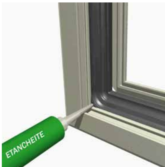
Injection de butyl dans la pièce d'angle
