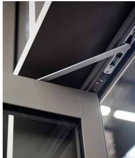
Ferme-porte encastré dans la traverse haute
